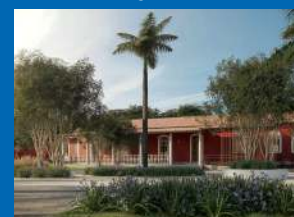
Clube Aretê Búzios - Nova Sede Social em construção
